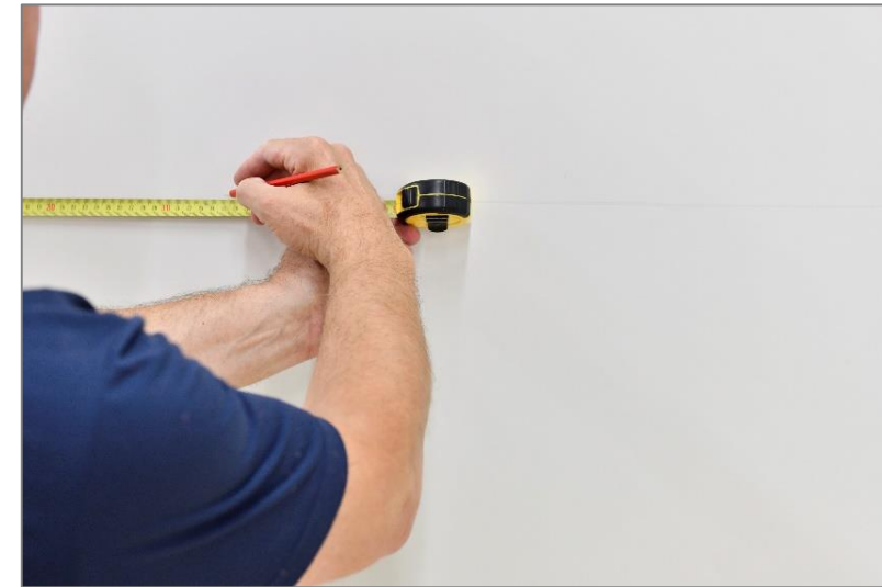
Pointages des supports muraux.
