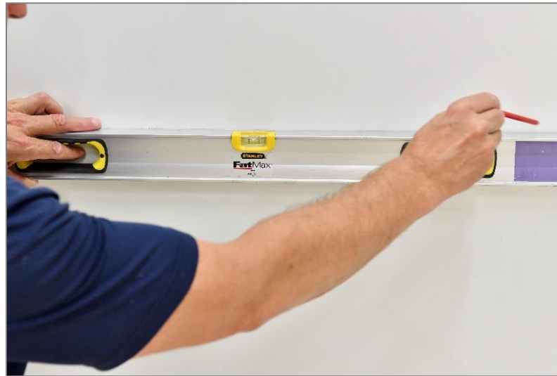
Traçage de mise à niveau des supports muraux.
